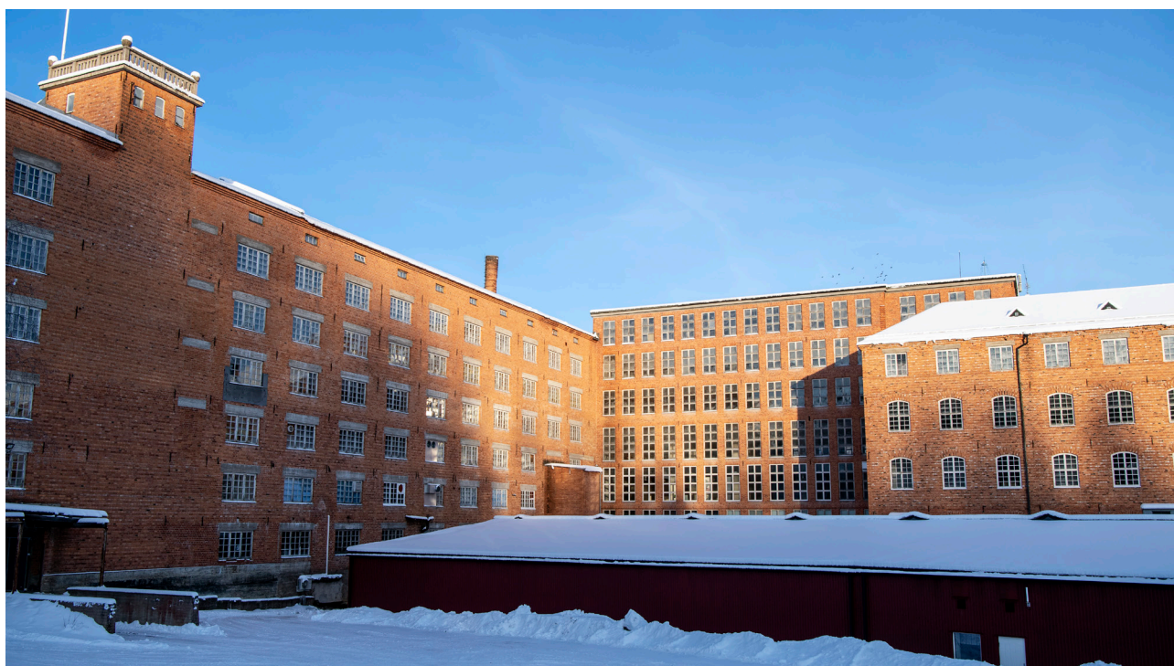
Gamla yllefabriken i Sågmyra.
