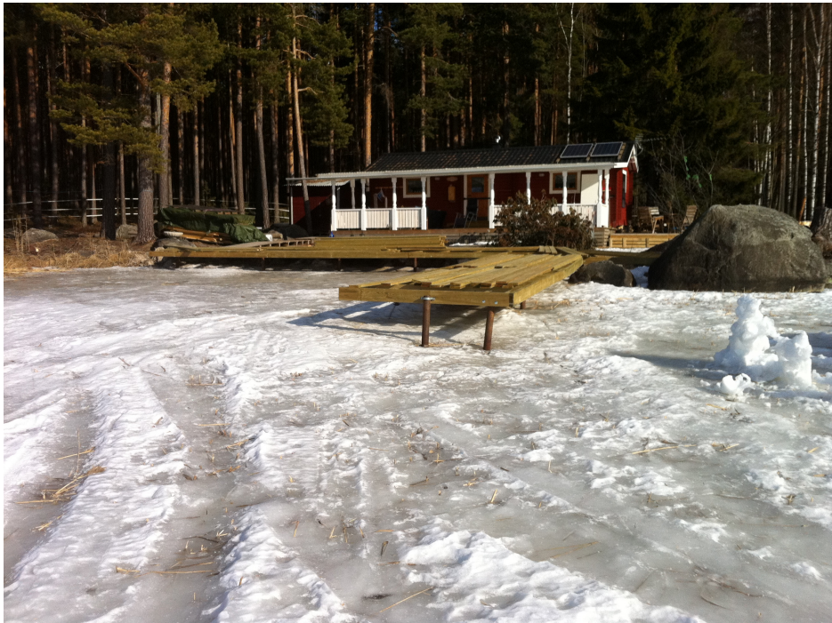
Bild 4. Närmast på bilden är bryggan som var under uppförande vintern 2013.
