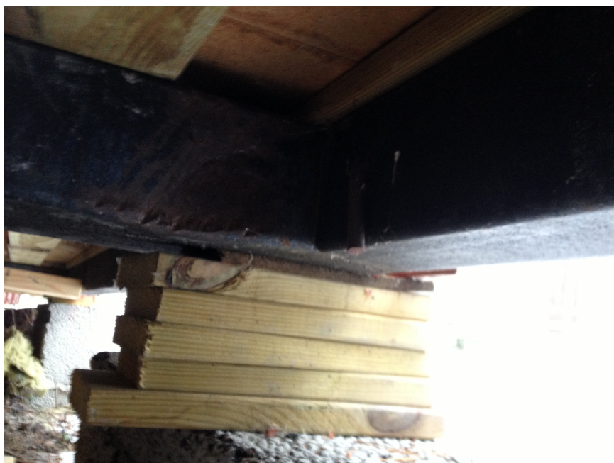
Bild 7. Detaljen visar stålbalken som husets överbyggnad är byggt på.
